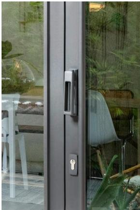
Profils intégrés pour faciliter l'ouverture extérieure
